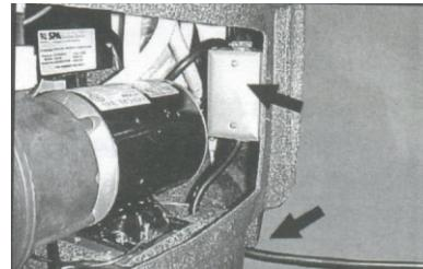
Образец установленной соединительной коробки. Заведите кабель питания в коробку через ее нижнее отверстие.
